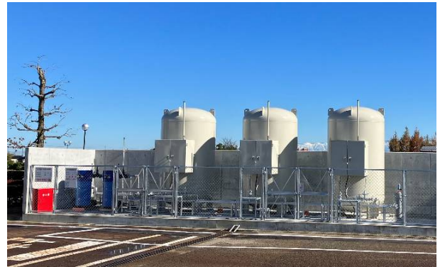
北陸工場のボイラー燃料転換
