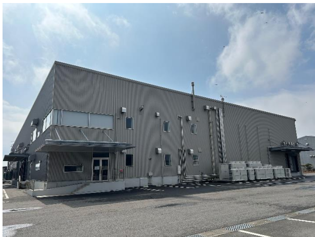
エキス製造工場外観
