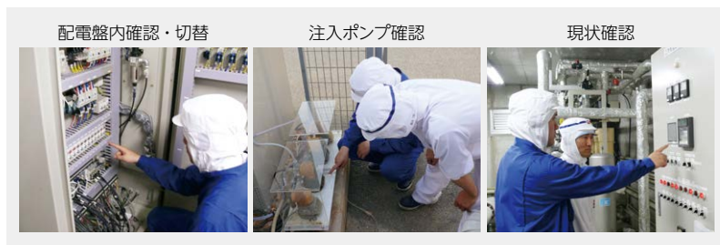
工業用水処理設備異常の訓練
