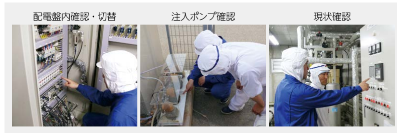
工業用水処理設備異常の訓練
