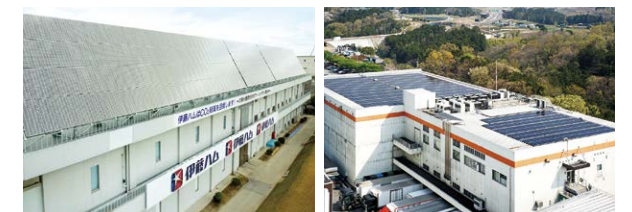
太陽光パネル (伊藤ハム西宮工場)
