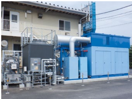
浅草ハムの関東工場に導入したコージェネレーションシステム
