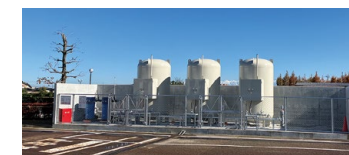
北陸工場のボイラー燃料転換
