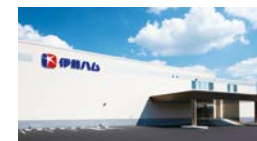
取手第二工場
