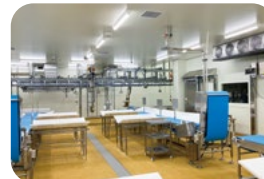
カット室の天井下げ
