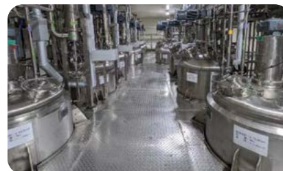
エキス製品の生産設備
