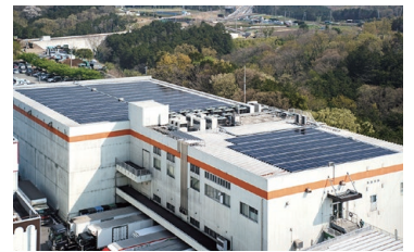
太陽光パネル（米久本社物流センター）
