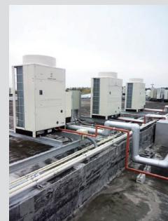
効率の良い冷凍機（伊藤ハム豊橋工場）
