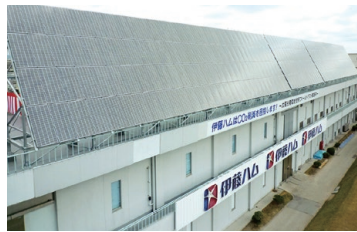
太陽光パネル（伊藤ハム西宮工場）
