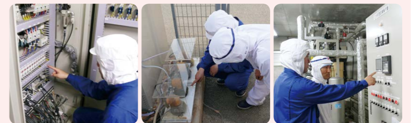
配電盤内確認・切替
