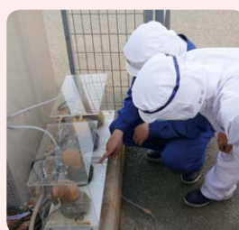
注入ポンプ確認
