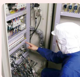
配電盤内確認・切替
