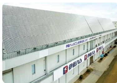
太陽光パネル (伊藤ハム西宮工場)
