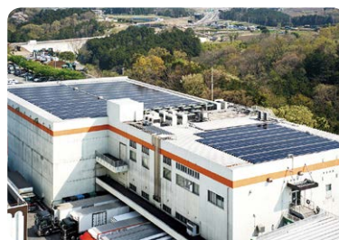
太陽光パネル (米久本社物流センター)
