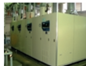
省エネ推進のため導入した 小型貫流ボイラー (豊橋工場)
