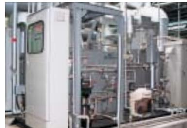
エンジンの廃熱を回収する排ガスボイラ
