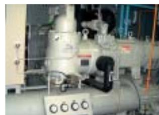
アンモニア冷媒の冷凍設備(九州工場)
