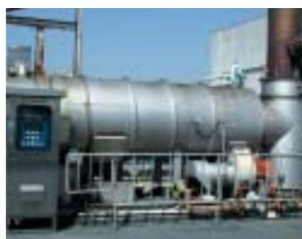
ガス式消煙装置(西宮工場)
