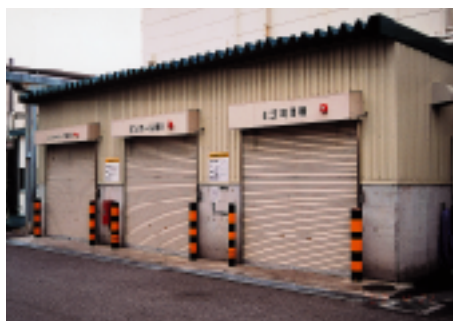
エコステーション(船橋工場)
