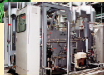
エンジンの廃熱を回収する排ガスボイラー
