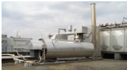
ガス式消煙装置(東京工場)
