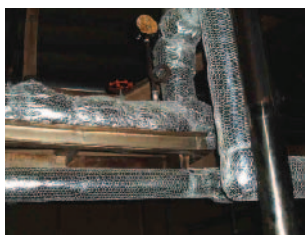
保温施工した蒸気配管（六甲工場）
