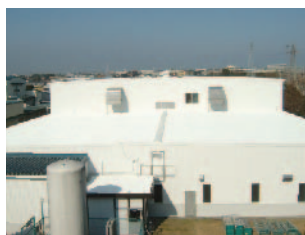
断熱効果の高い塗装（豊橋工場）
