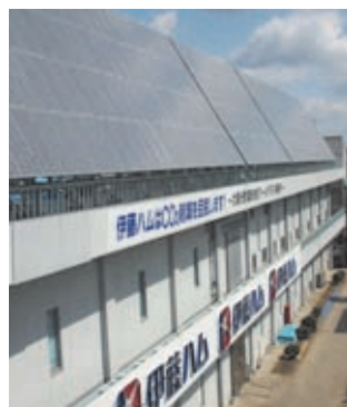
太陽光発電設備（西宮工場）
