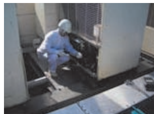
フロンガス漏洩対応訓練 (伊藤ハムデイリー(株)小樽工場)
