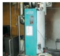
灯油からLPガスに燃料転換したボイラー、LPガス貯蔵設備 （IHミートパッカー（株）宮城ミートセンター）
