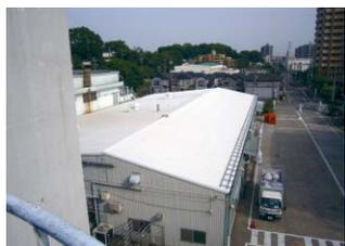
断熱効果の高い塗料による屋根の塗装(東京工場)
