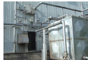
蒸気ドレン水の貯水タンク(豊橋工場)
