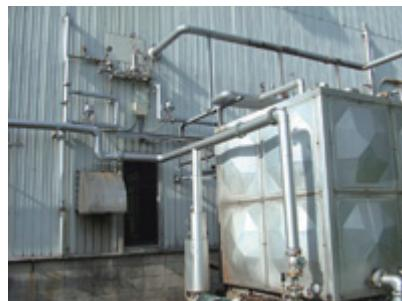
蒸気ドレン水の貯水タンク(豊橋工場)
