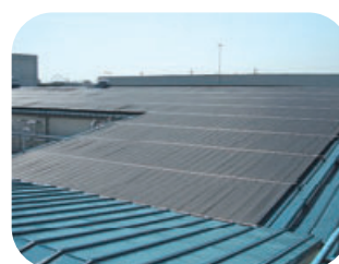
ルーフシェードを設置し、遮熱塗装した 工場屋根(豊橋工場)
