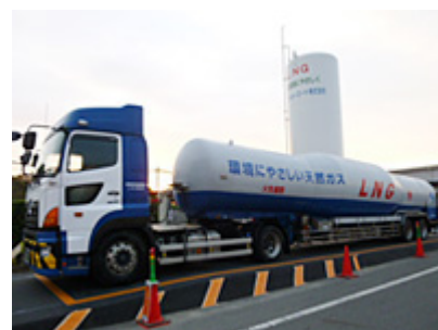
天然ガス受入状況および天然ガス貯蔵タンク（サンキョーミート(株)有明ミート工場）
